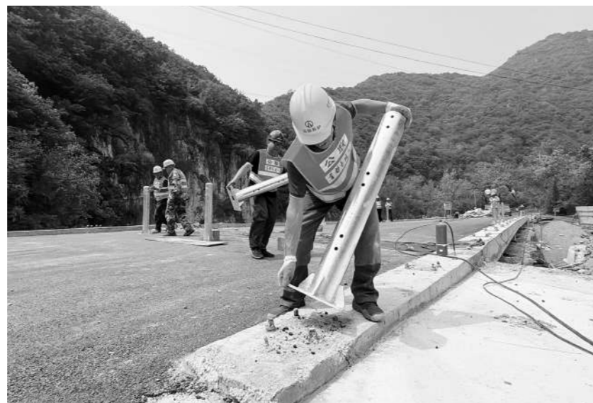
怀柔段水毁恢复重建工程第四标段现场。 ■记者 刘偶/摄
