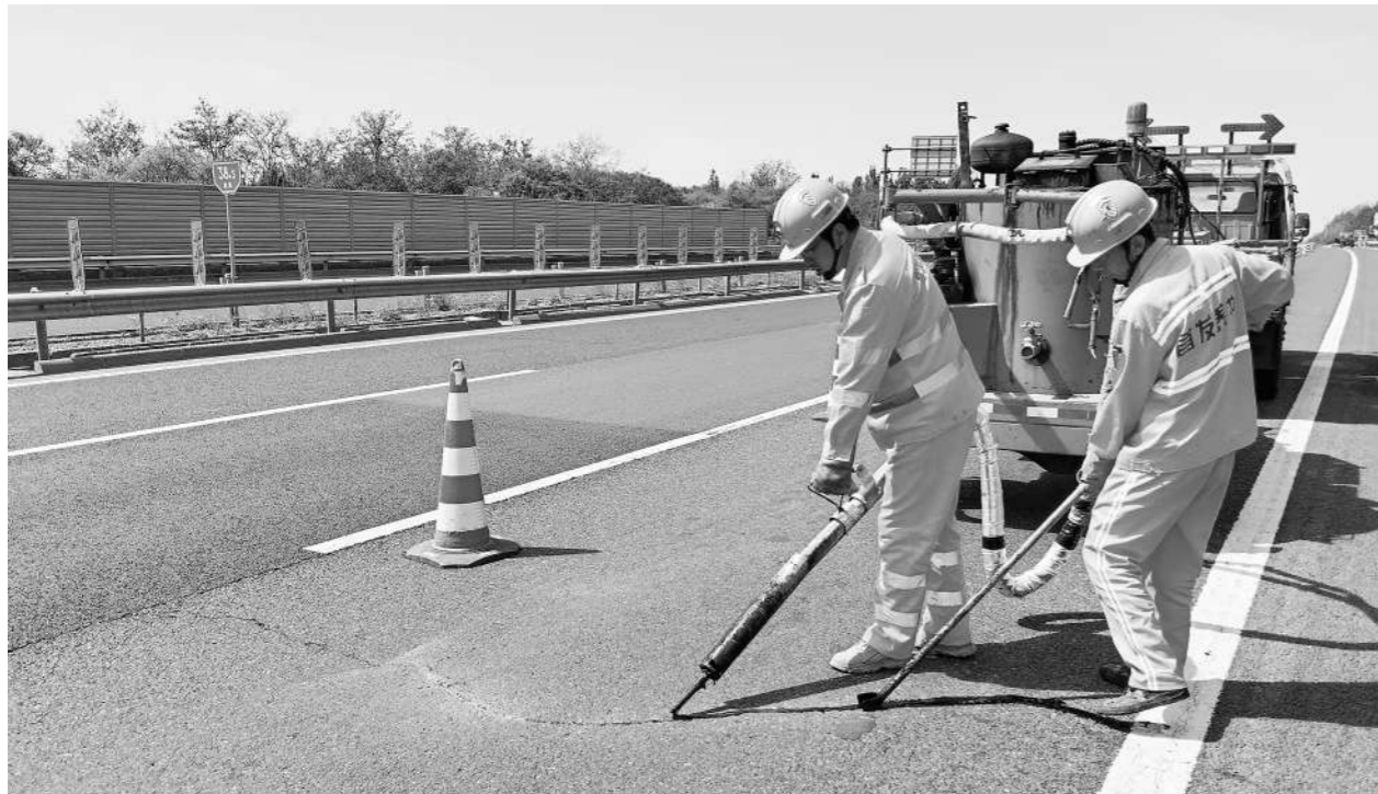
工作人员正在保畅节前道路。
